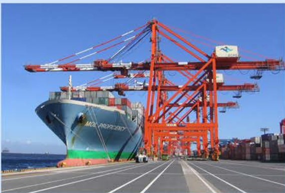
ガントリークレーン
